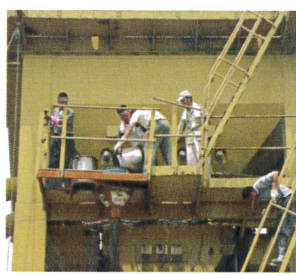
直接人力投入
