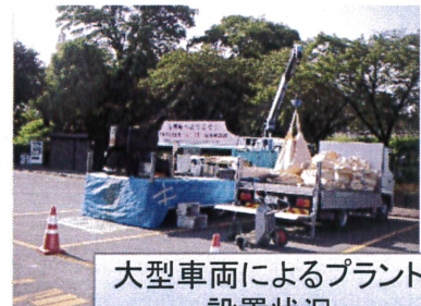
大型車両によるプラント 設置状況
